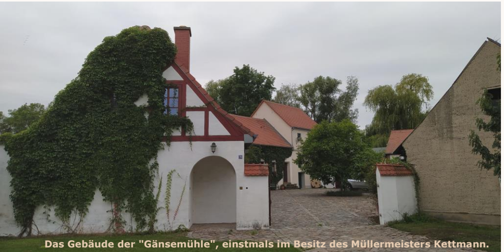
Das Gebäude der "Gänsemühle", einstmals im Besitz des Müllermeisters Kettmann.
