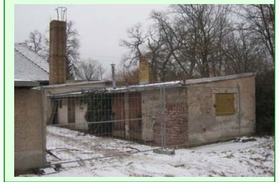
So sahen die Nebengebäude am 13.01.2013 aus
