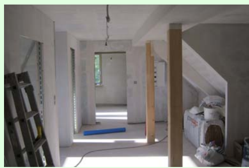
So sieht es heute im Dachgeschoss aus
