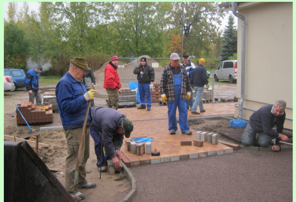
Die Freifläche des Bürgerhauses Mosigkau ist schon weit fortgeschritten – auch Dank der vielen Mosigkauer Helfer
