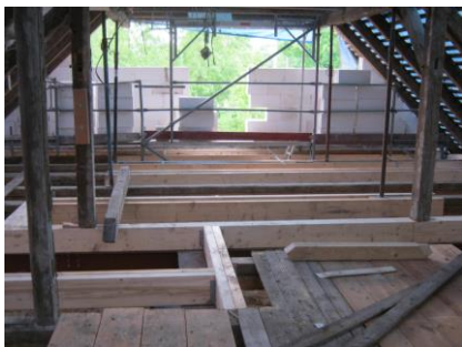
Blick in den Dachstuhl Richtung Parkplatz
