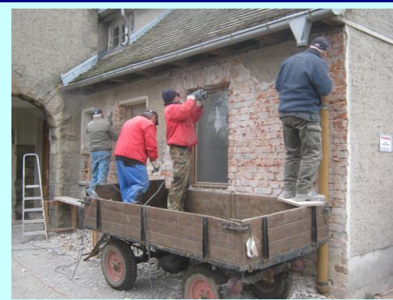
Unermüdlich waren die fleißigen Helfer am Werk – hier wird Putz entfernt
