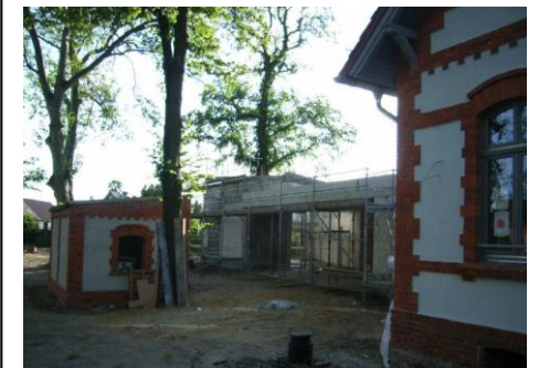
Der neue Anbau von der Knobelsdorffallee aus gesehen
