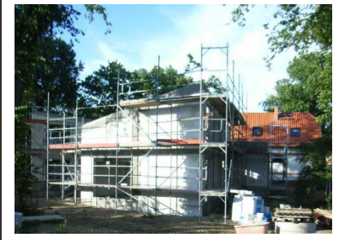
So sieht der neue Kindergarten von hinten aus
